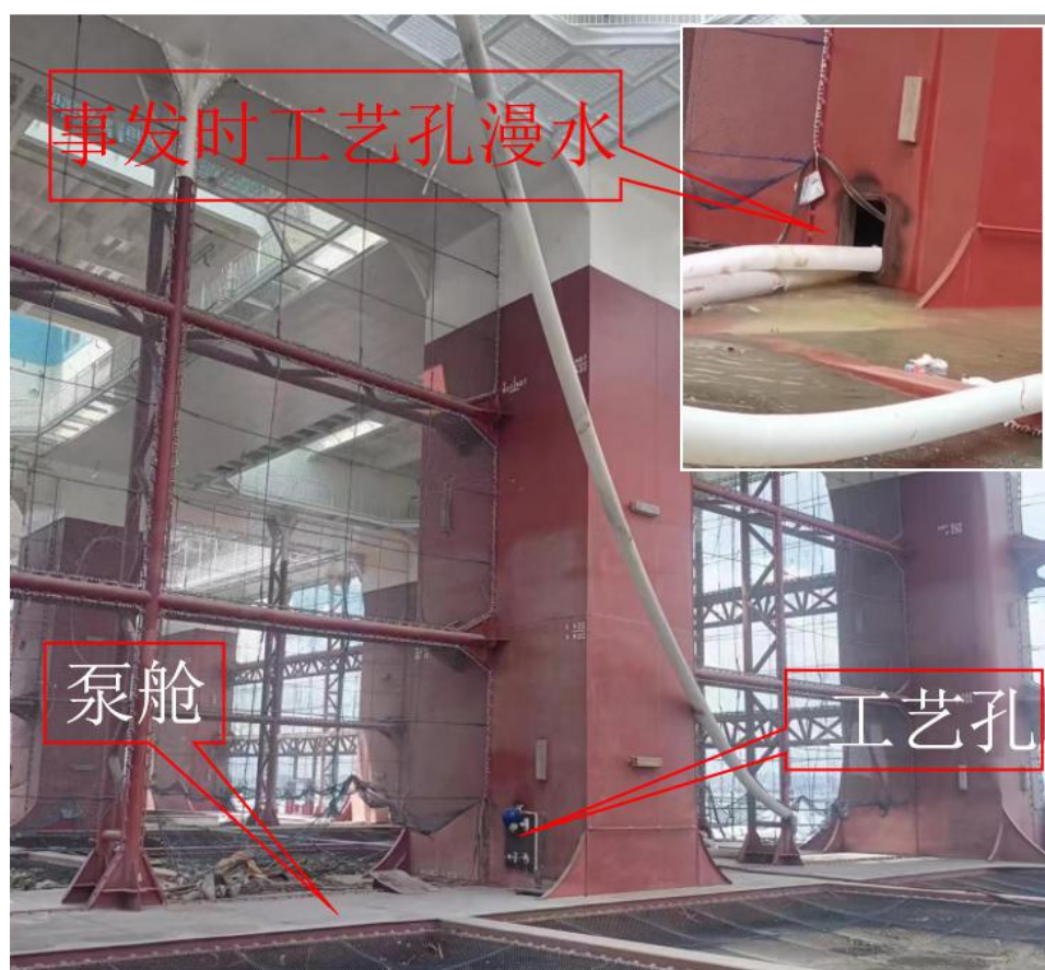
图3 “普盛海洋牧场 6 号”主甲板及泵舱情况
